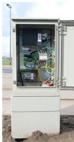
Une enceinte industrielle ou un boîtier routier contient le module d'acquisition de données et une unité de calcul industrielle. Le boîtier est installé à proximité de la voie jusqu'à une distance de 150 m.
